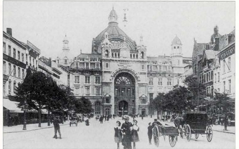
Het stationsgebouw werd opgetrokken door De la Censerie in de periode 1898-1905.
