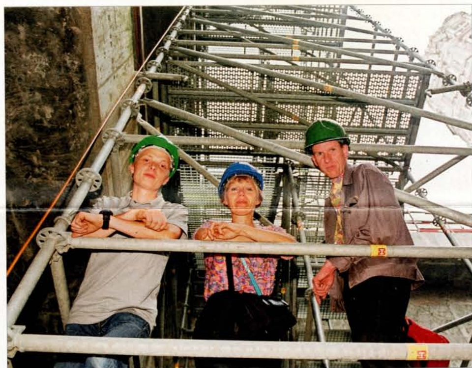
Stijn Slabbinck, Anne-Mie Van Kerckhoven en Danny Devos toveren de spoortunnel onder Antwerpen-Centraal om tot een kunstwerk.
